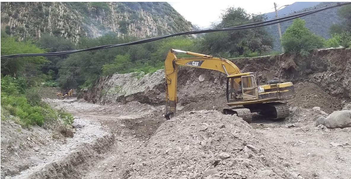
Imagen 13.-Comunidad de Tecruz de Anáhuac, desazolve de arroyo.
