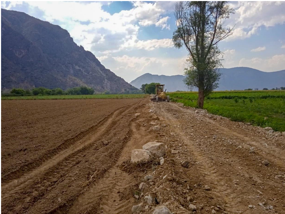
Imagen 3.- Revestimiento de calzada El Cerrito – La Punta de Hualula.
