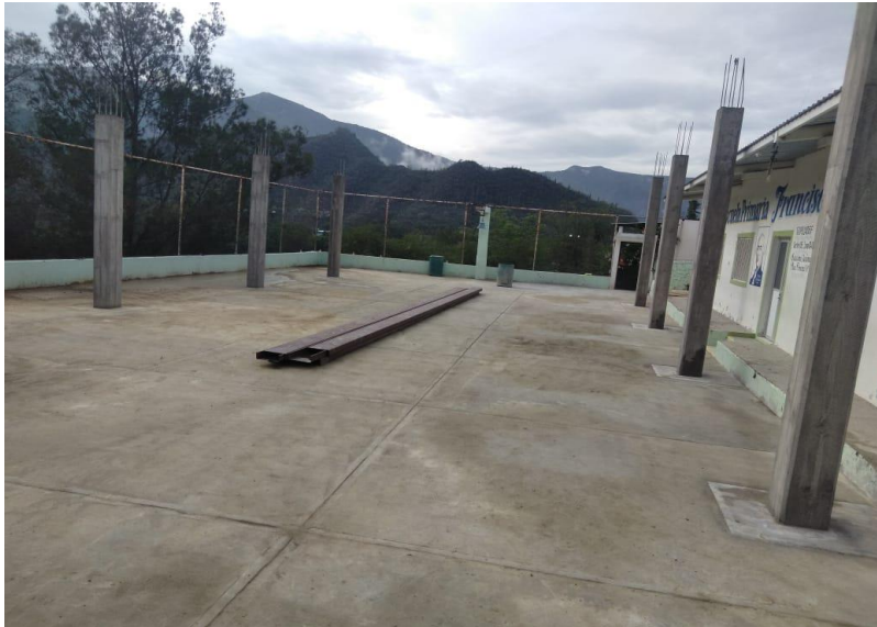
Imagen 9.-Acalome Apoyo con material para la construcción de columnas para techumbre.
