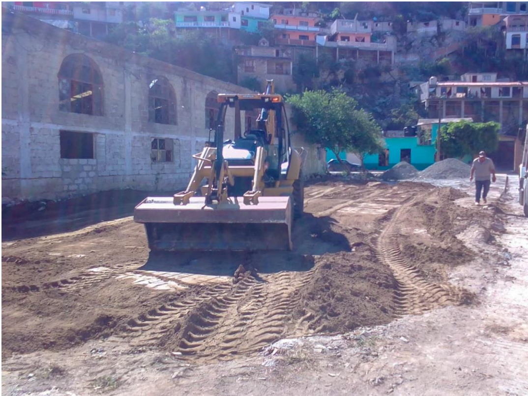
Imagen 12.- San Cristóbal nivelación de terreno.
